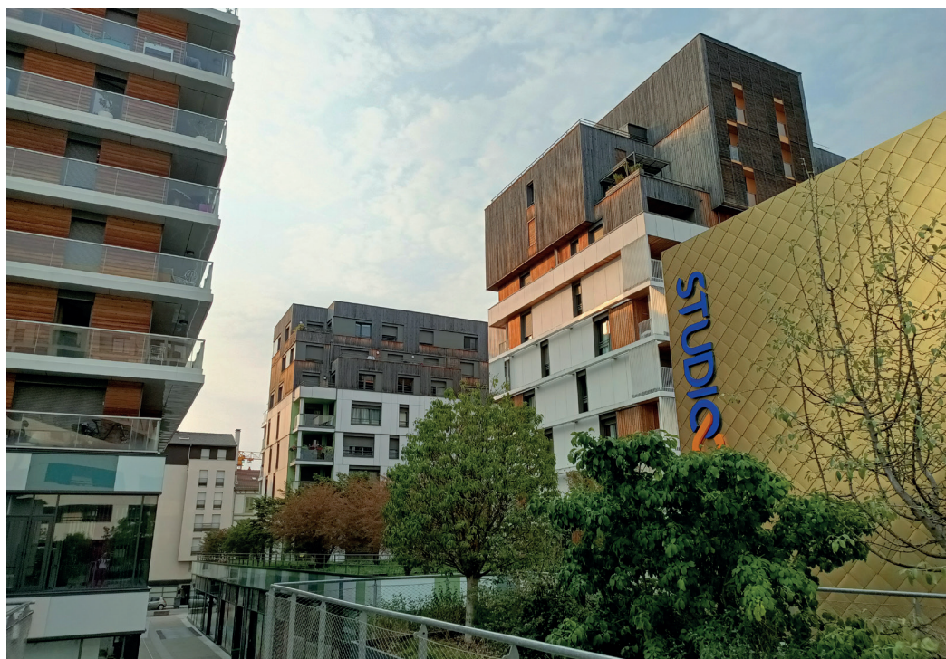
Toiture végétalisée intensive : Chablais parc, Annemasse. Référence indicative.
