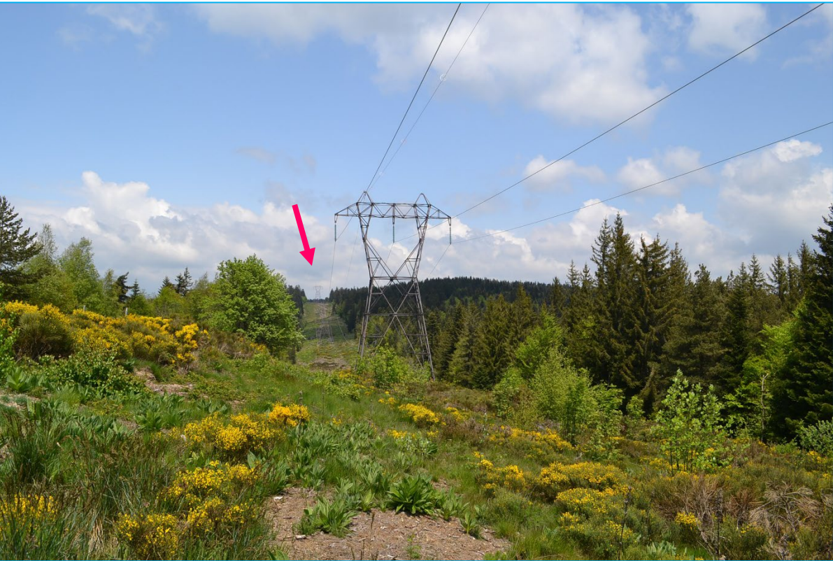
Figure 5 : Pylônes n°40 (au second plan) et 41 (au premier plan) : situation actuelle
