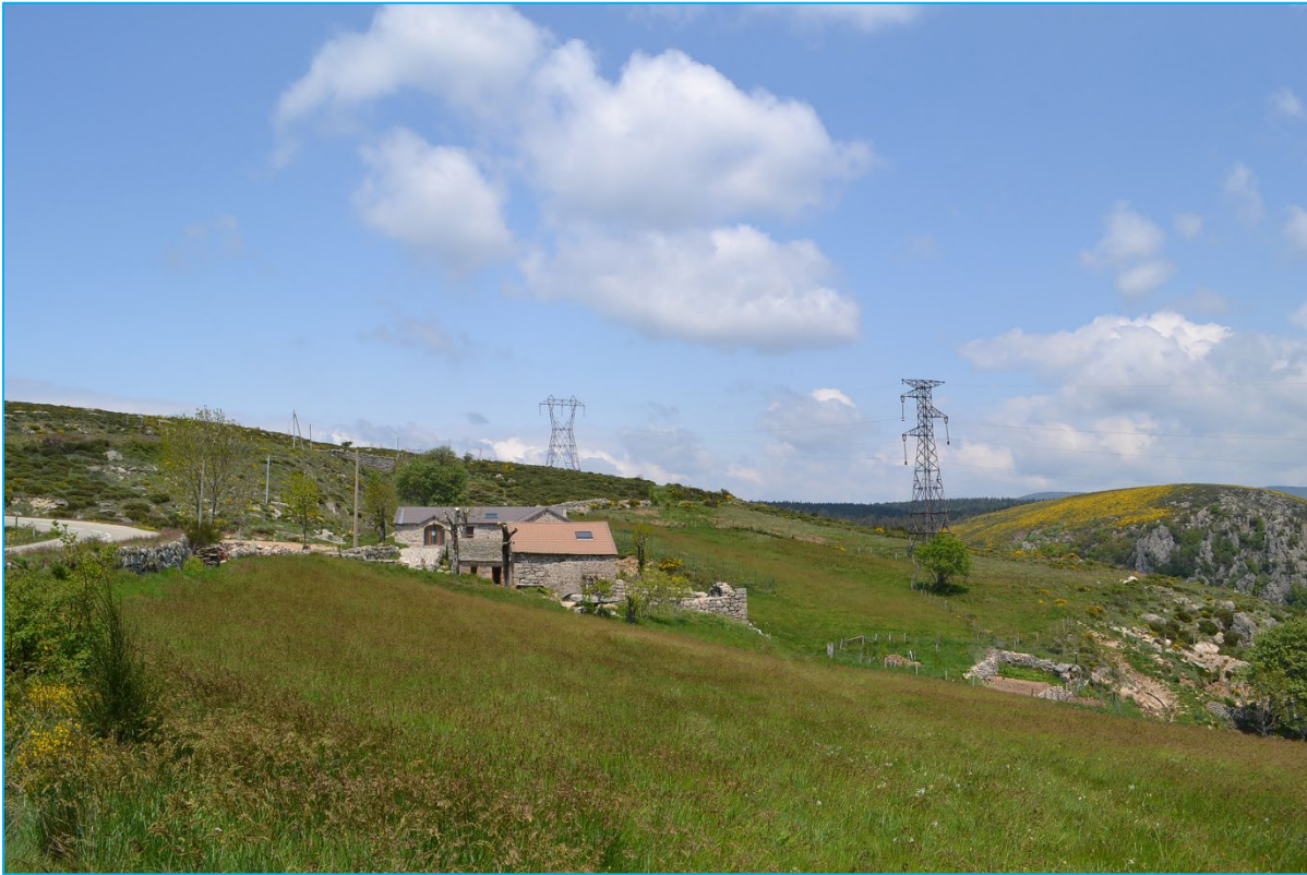
Figure 7 : Pylônes n°45 (à gauche) et 46 (à droite) : situation actuelle
