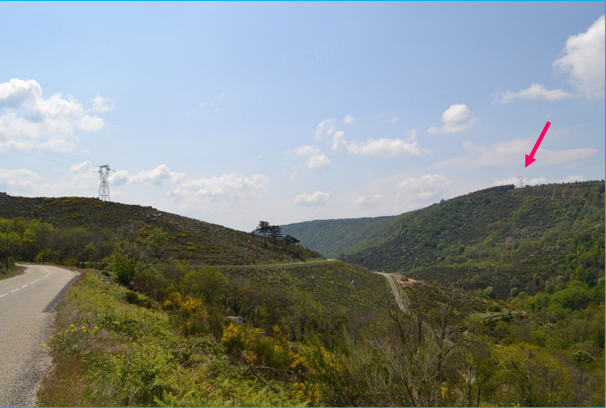
Figure 9 : Pylônes n°57 (à gauche) et 58 (à droite) : situation actuelle
