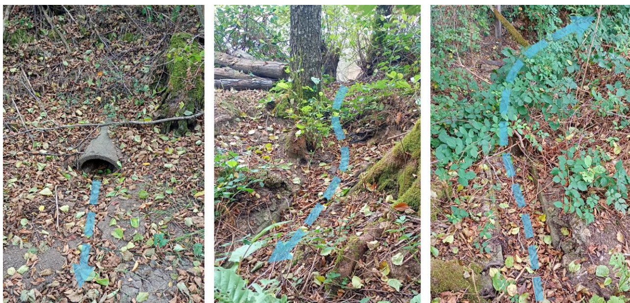
Alimentation complémentaire étang haut (Ø 300mm depuis fossé assec) et canal de surverse (photo 2 et 3)
