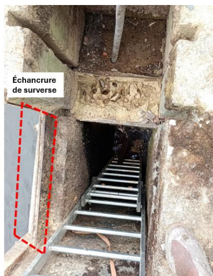
Détails moine hydraulique étang bas
