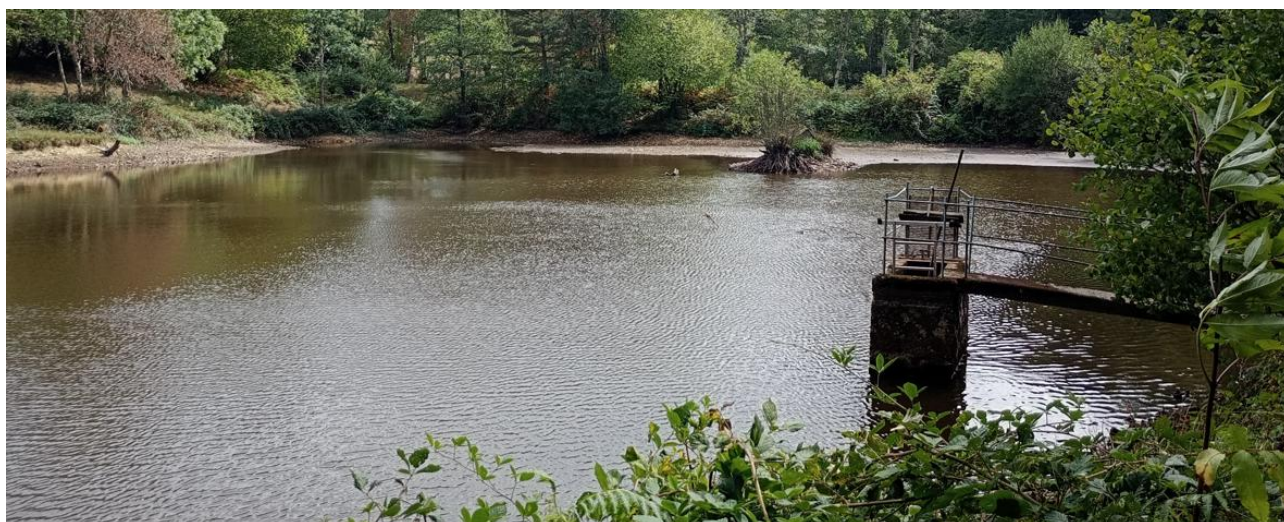
Vue générale étang bas + moine hydraulique
