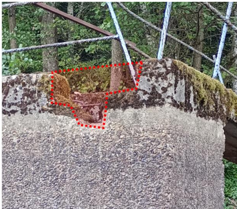
Reprise canal de surverse et fermeture échancrure sur moine
