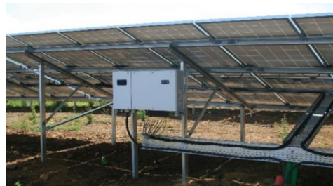
Figure 11 : Exemple d'onduleurs –
