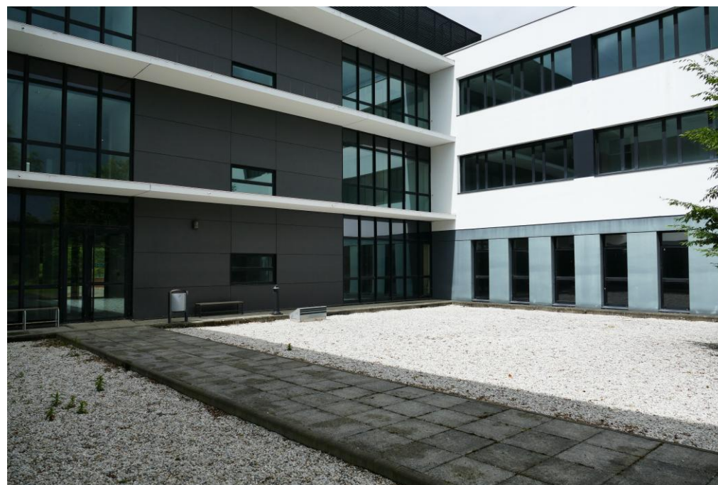
Bâtiment en très bon état
