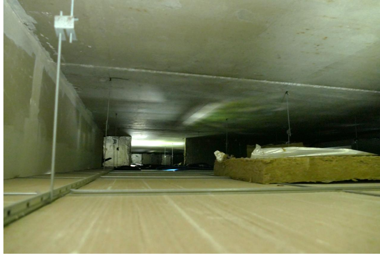
Les combles sous les faux plafonds
