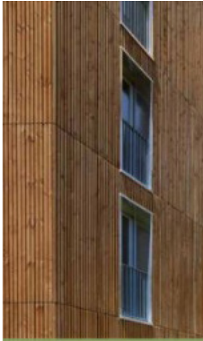
Bardage bois faux claire-voie
