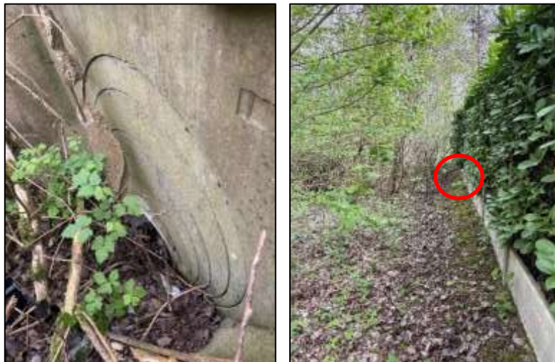
Figure 11 : Busage du fossé en amont de la STEP
