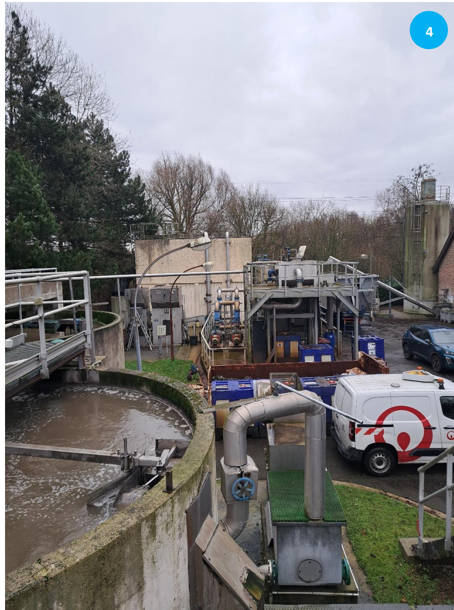
Photographie n°4, prise le 15/01/2026
