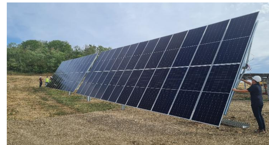
Figure 13 : Installation des panneaux (source : TSE)
