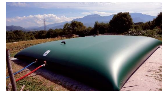
Figure 21 : Exemple de citerne incendie souple
