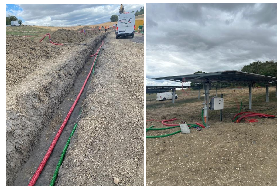
Figure 24 : Illustration de tranchées de câbles (source : TSE)
