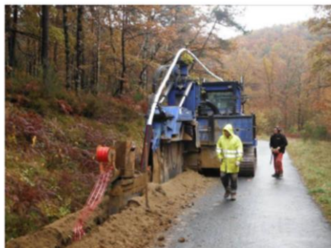
Figure 26 : Pose de câble à la trancheuse
