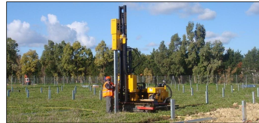
Figure 4. Sonnette de battage hydraulique
