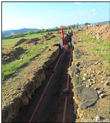
Photo 4 : Tranchée pour câblage
