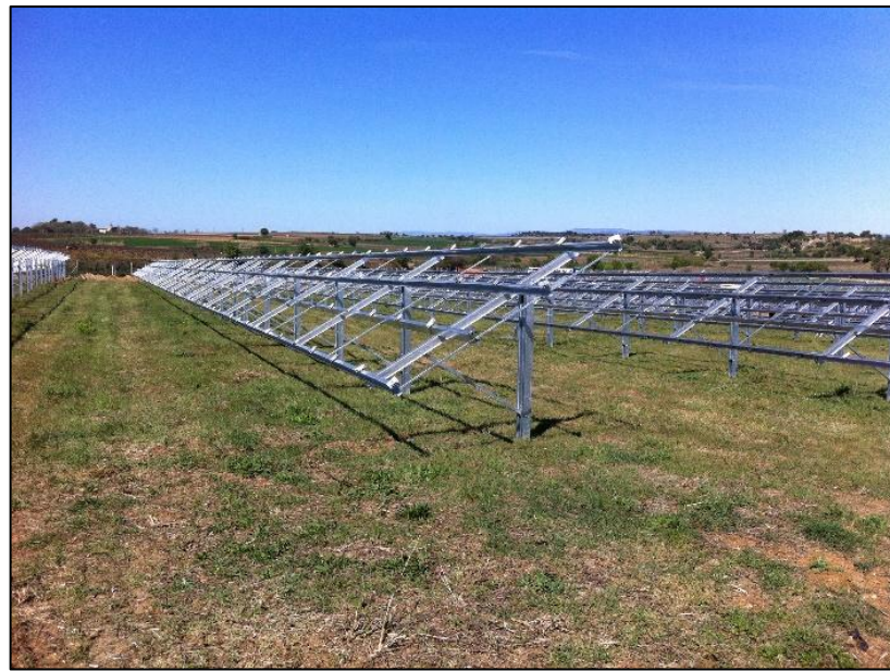
Photo 1 : Exemple de structures fixes
