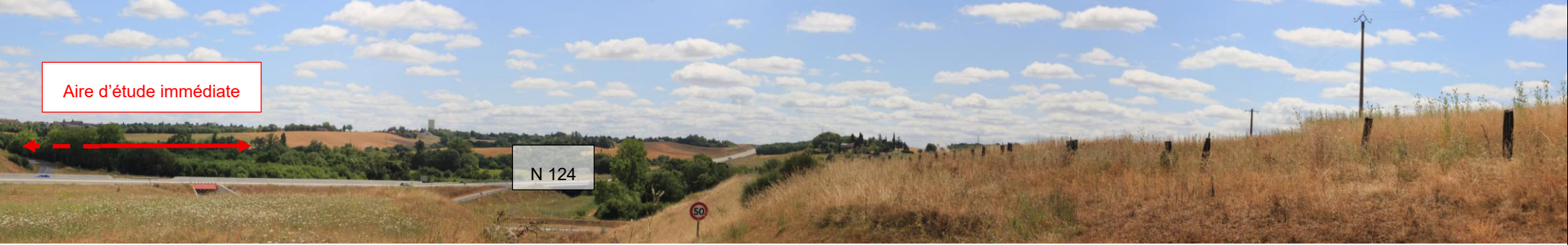
Photo 18 : Point de vue n°9 – Vue proche de N124
