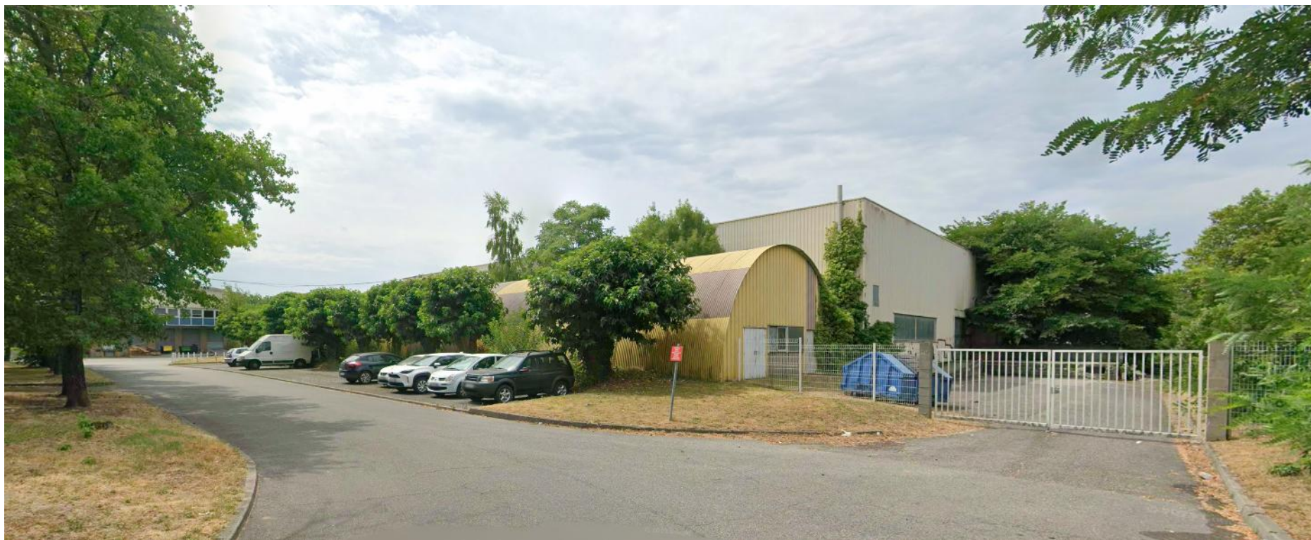
Prise de vue 4 : A Nord de l'emprise du projet – depuis la route d'accès (Google Maps – Juillet 2025)
