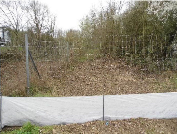
Figure 8. Illustration de barrières en géotextile disposées en partie basse de clôtures de chantier.
