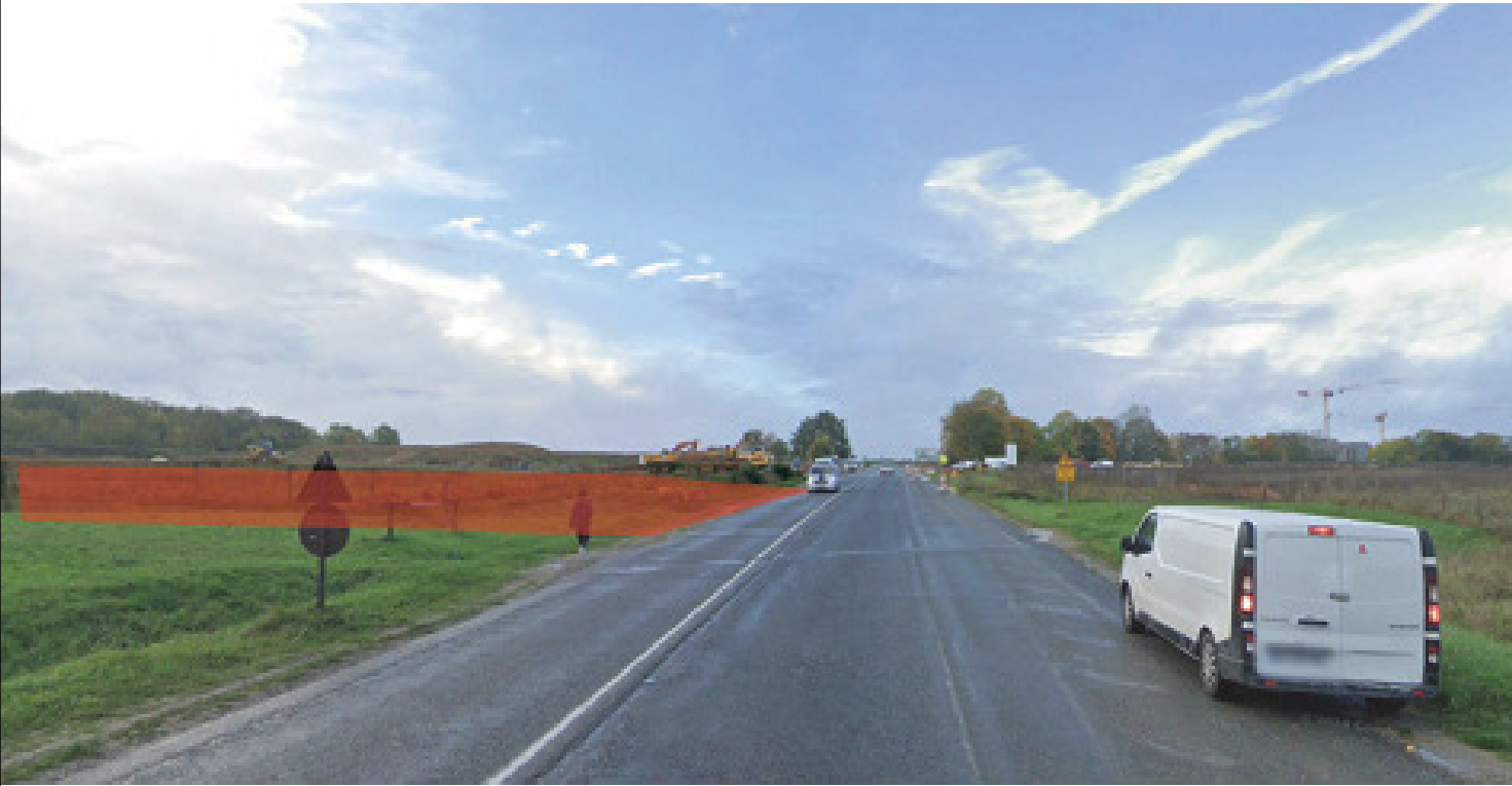
POINT DE VUE 3 (Départemental D5)
