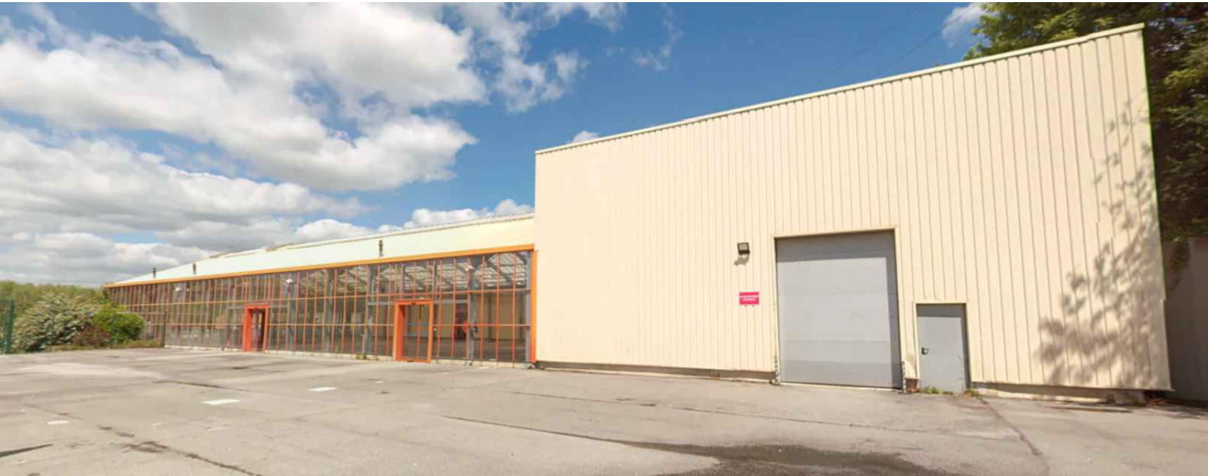
Vue proche - Vue de la façade latérale côté arrière
