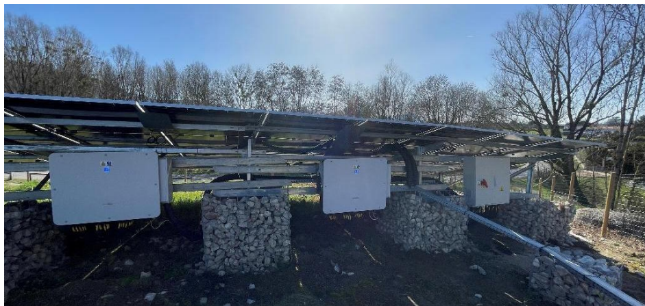
Fixation des onduleurs aux structures (St Cergues – 74)
