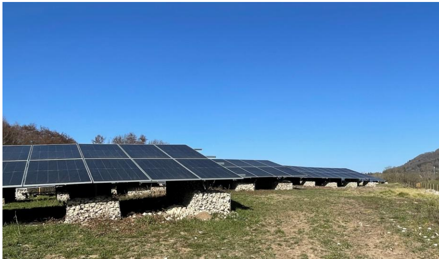
Exemple de structures lestées avec des gabions : parc PV de St Cergues (74) – ancienne décharge – Enercoop AURA
