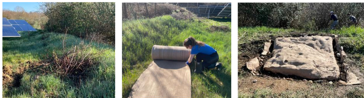
Pose d'un géotextile croisé sur un pied de renouée avant recouvrement sur notre site de St Romans (38)
