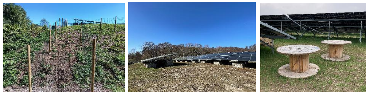
Photographies d'illustration de la phase de travaux
