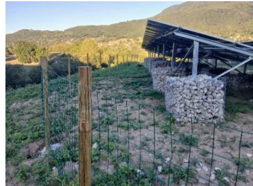
Exemple de structures fixes, parc PV de St Cergues (74)
