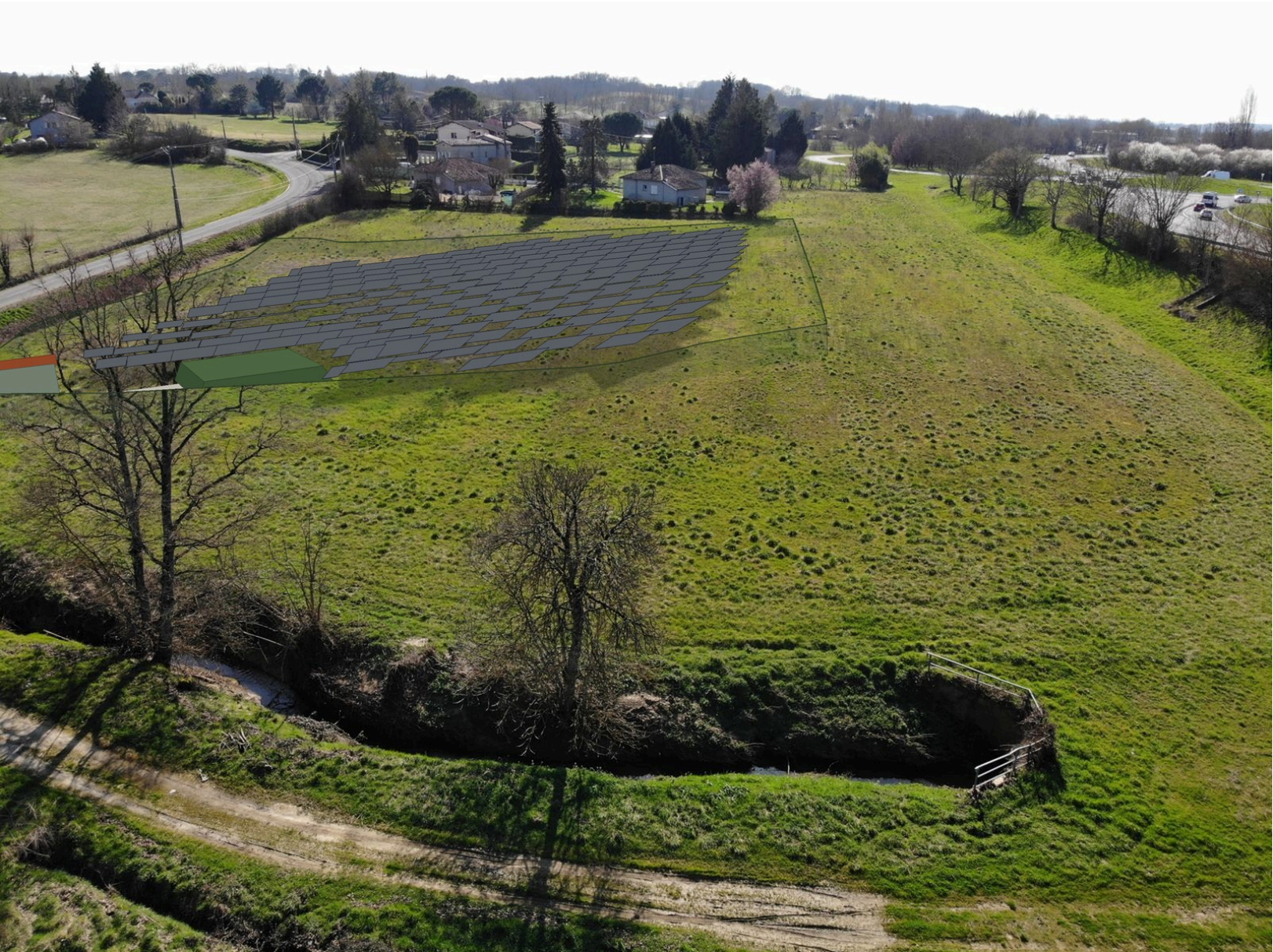
Prise de vue drone à ≈ 21 m — depuis Caussade, l'îlot est perçu (faces arrière des tables) derrière la ripisylve conservée du ruisseau de Bonne Vieille ; le local technique à toiture 2 pans en tuiles et la réserve incendie sont implantés à l'est de l'îlot, près de l'accès existant.
