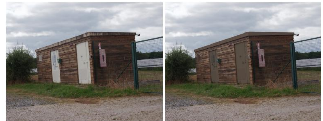
Figure 9 : Exemple d'un poste de livraison avec platelage bois Source : RESONANCE
