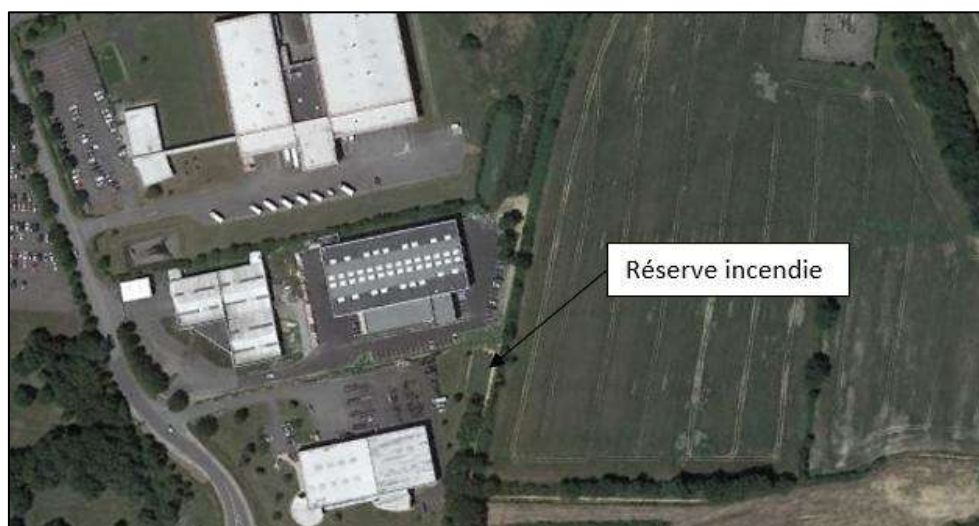
Figure 117 : Localisation de l'actuel bassin de réserve à incendie (source – TECAM)
