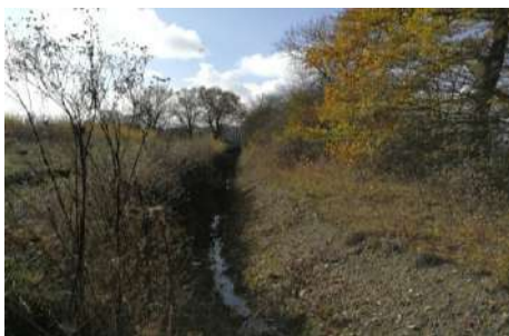
Photo 7 : Fossé de régulation des eaux pluviales, réalisation temporaire entreprises existantes (source – EF Etudes le 02/2019)
