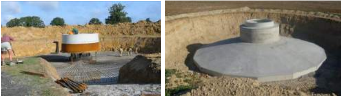
Figure 31 : Le ferrailage et le coulage d'une fondation d'éolienne
