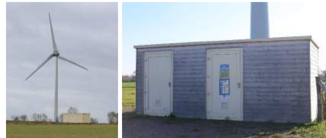
Figure 33 : Exemples de poste de livraison électrique
