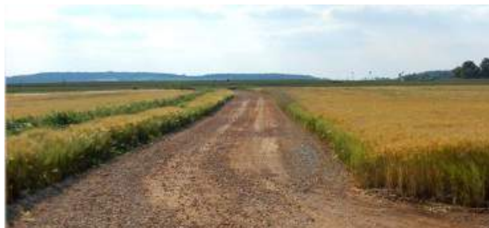
Figure 32 : Exemple de voie d'accès à un parc éolien
