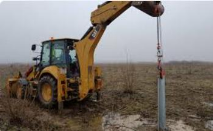
Figure 8 : Exemple de l'enlèvement des pieux (Source : ELEMENTS).
