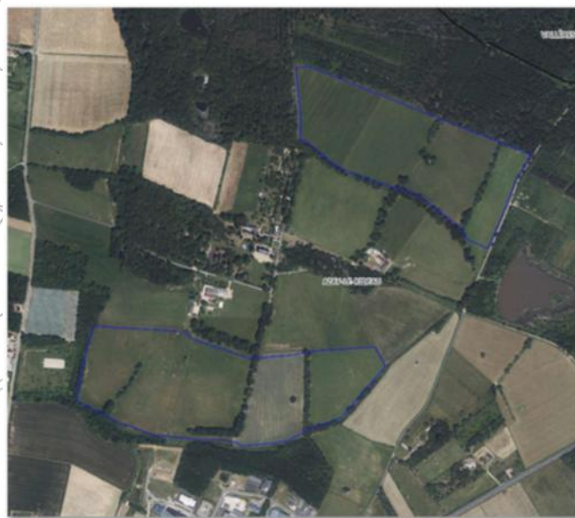
PHOTO AERIENNE DE L'EMPRISE DU PROJET AGRIVOLTAÏQUE (DOSSIER PC. P.6)
