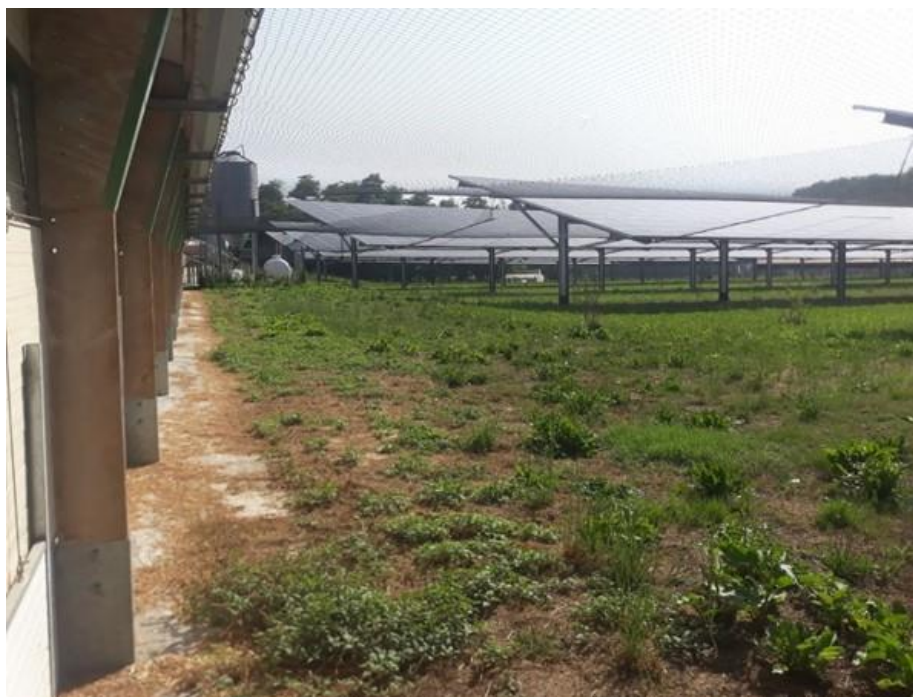
Figure 5 : Photographie d'une volière agrivoltaïque de Technique Solaire dans le cas d'un élevage de poulets de chair, avec à gauche le bâtiment d'élevage relié directement aux panneaux solaires et à la clôture périphérique, formant un clos total.
