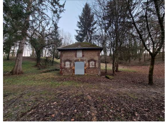
© Ville de Charleville-Mézières – Février 2025 Maison des espaces verts en haut du Mont-Olympe à droite sur le plan de zonage
