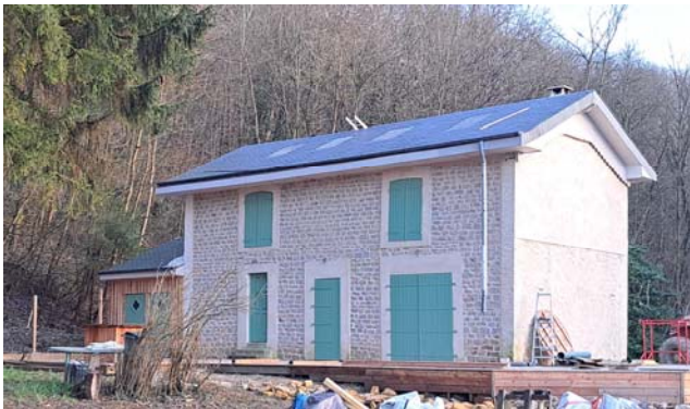
© BE Dumay – Février 2025 Bâtisse réhabilitée rue du Bois en Val peu avant la station d'épuration
