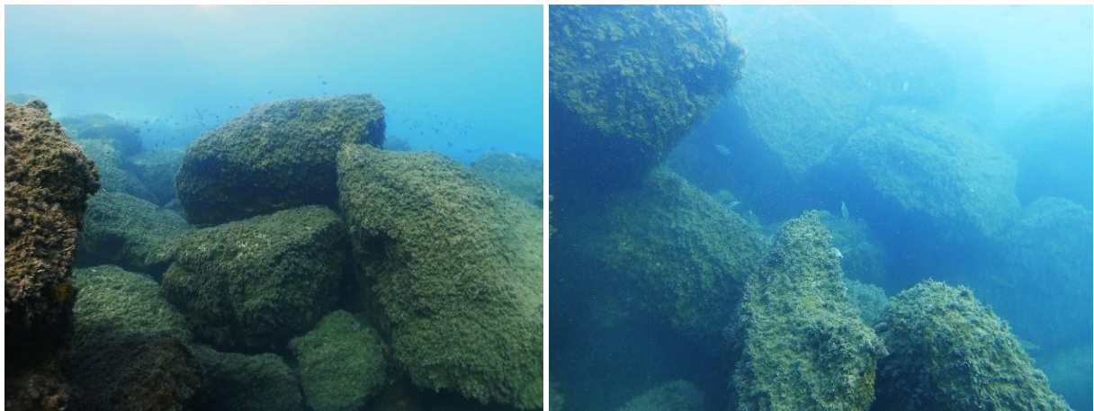
Figure 11 - Enrochements de la digue (P2A Développement, 2025)
