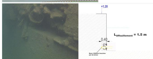
Figure 8: Affouillements à réparer
