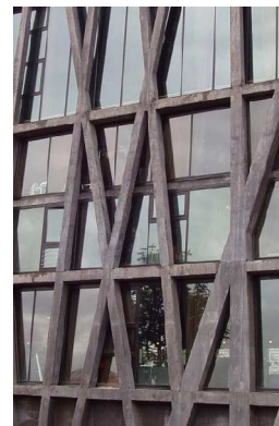
Exemple de béton teinté dans la masse (Pavillon Noir R Ricciotti - Aix 2007 - © 2011 TRAAC.INFO )
