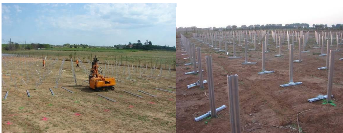
Battage des pieux
