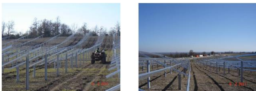
Figure 15 : Montage des structures porteuses
