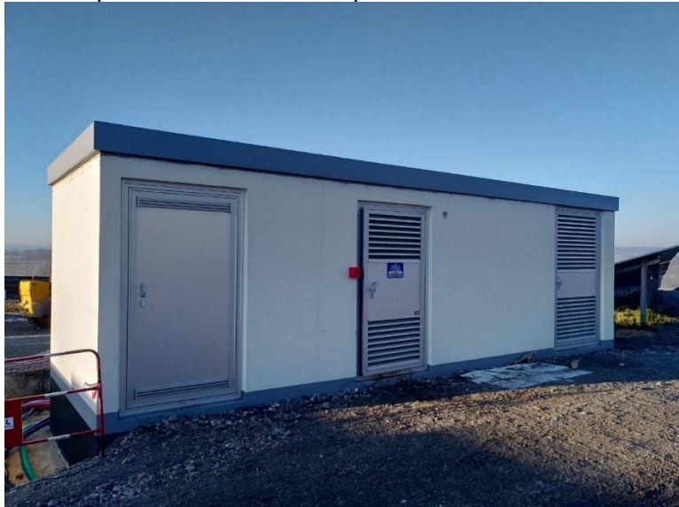
Figure 8 Photographie d'un poste de livraison/transformation
