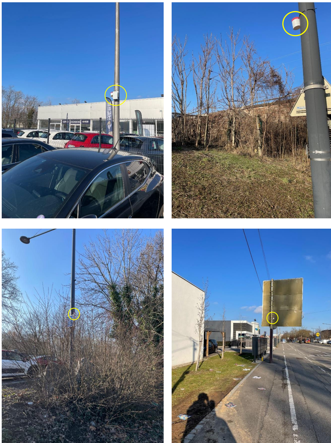
Figure 7 – Photographies des capteurs en place
