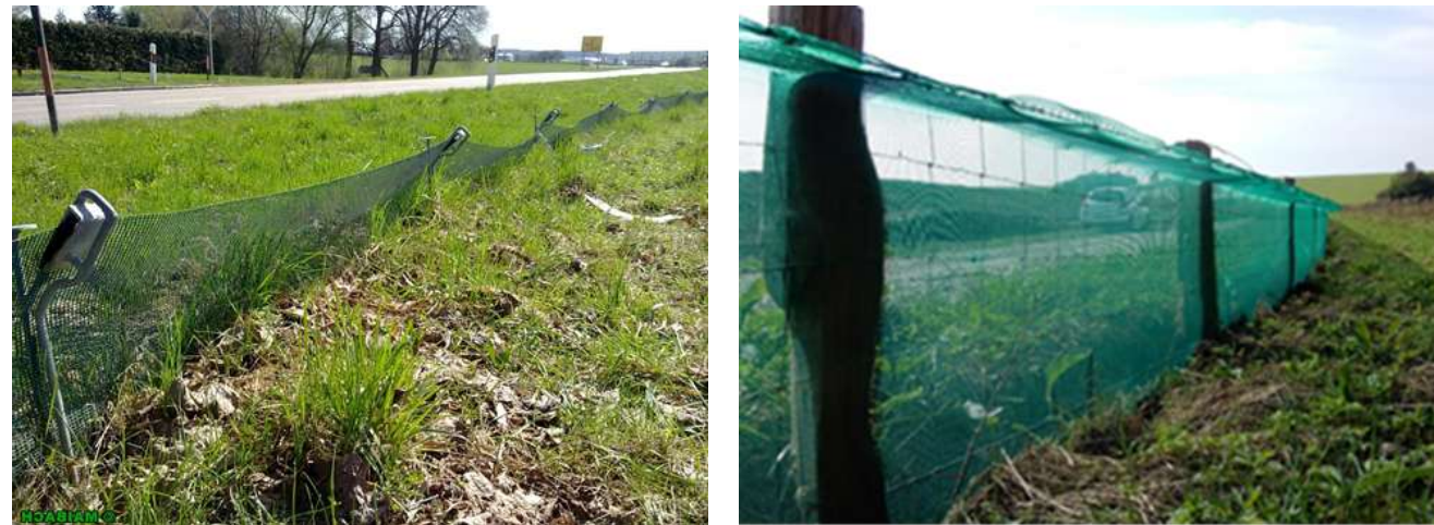
Figure 18 : Exemples de clôtures infranchissables pour ces taxons
