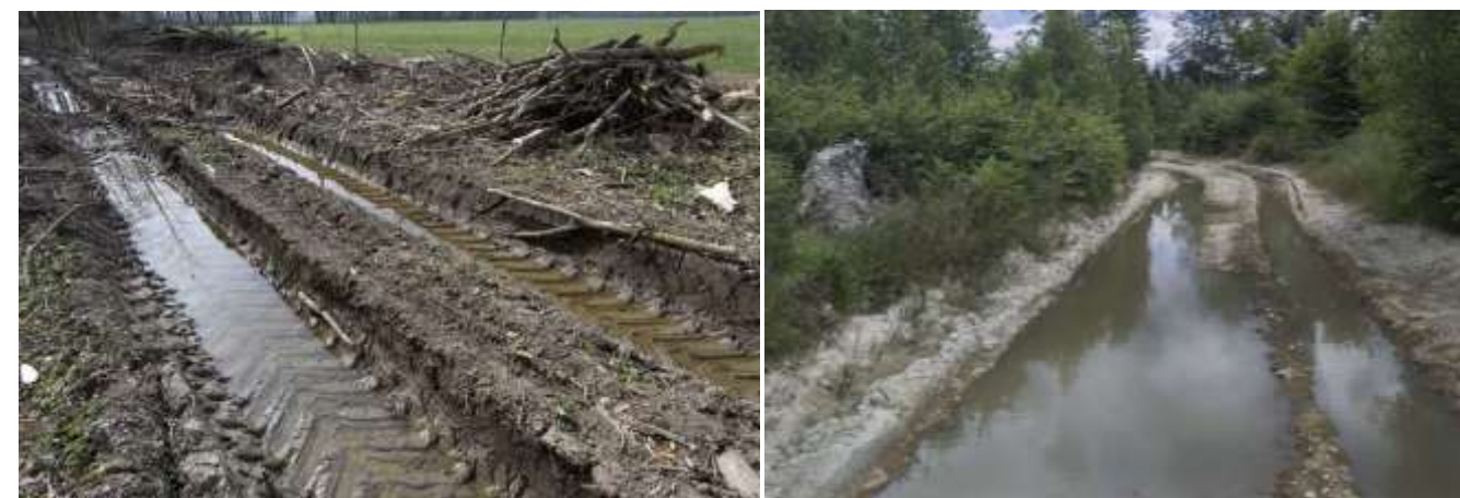
Figure 17 : Exemple d'ornières et dépressions à éviter
