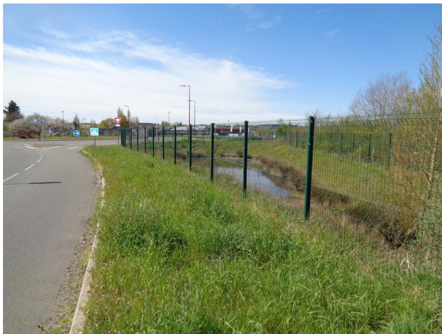
Bassin de la zone d'activités
