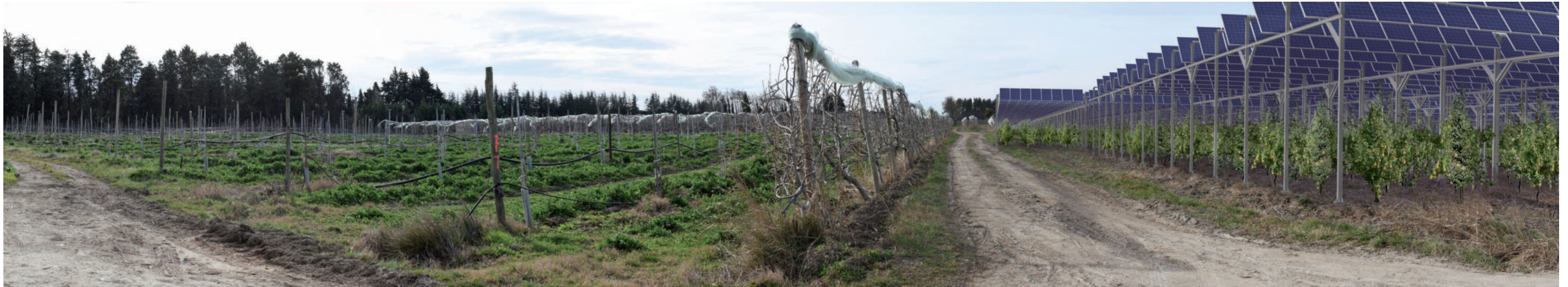
Photographie 24 : Vue initiale sur le projet avec le projet Thor 1 depuis les abords de l'habitation la plus proche, à moins de 100 m du projet (repère 2 carte précédente)
