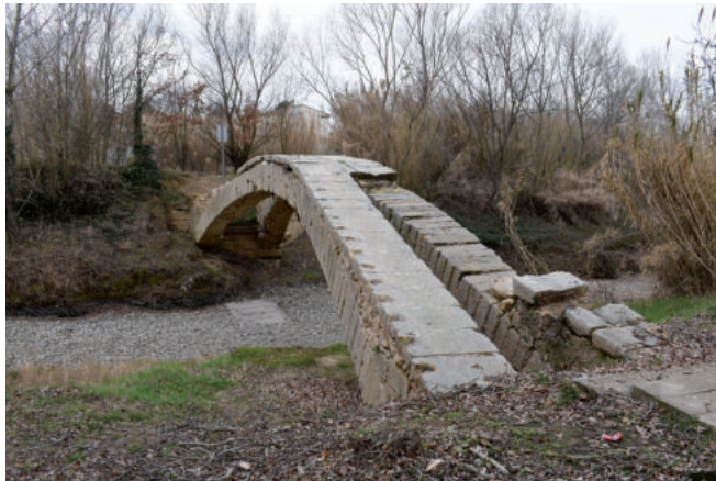
Photographie 7 : Pont aqueduc du Canal (MH n°17)
