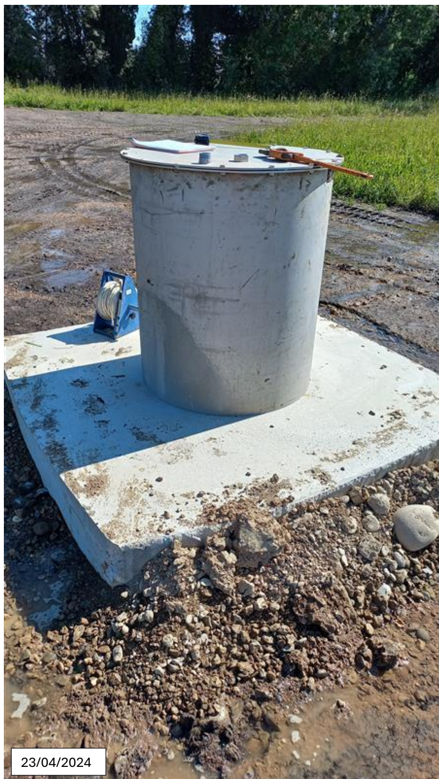
Forage du champ captant Nord N1
