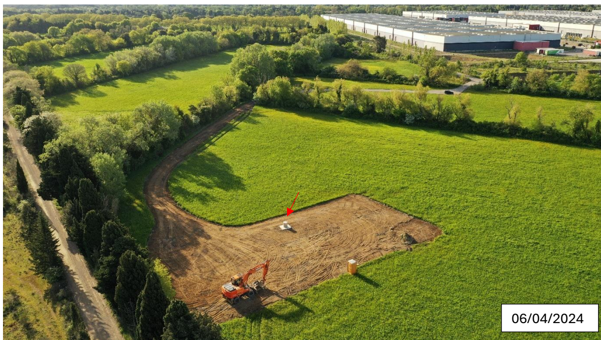
Vue aérienne du forage
