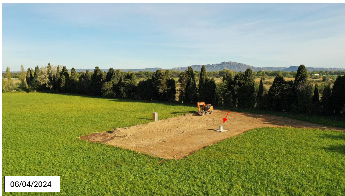
Vue aérienne du forage
