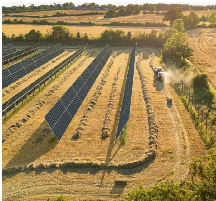
Exemple de centrale agrivoltaïque tracker 2V26 avec presse à botte carré, travail de la centrale avec les panneaux en position dos à dos (Source JPee)
