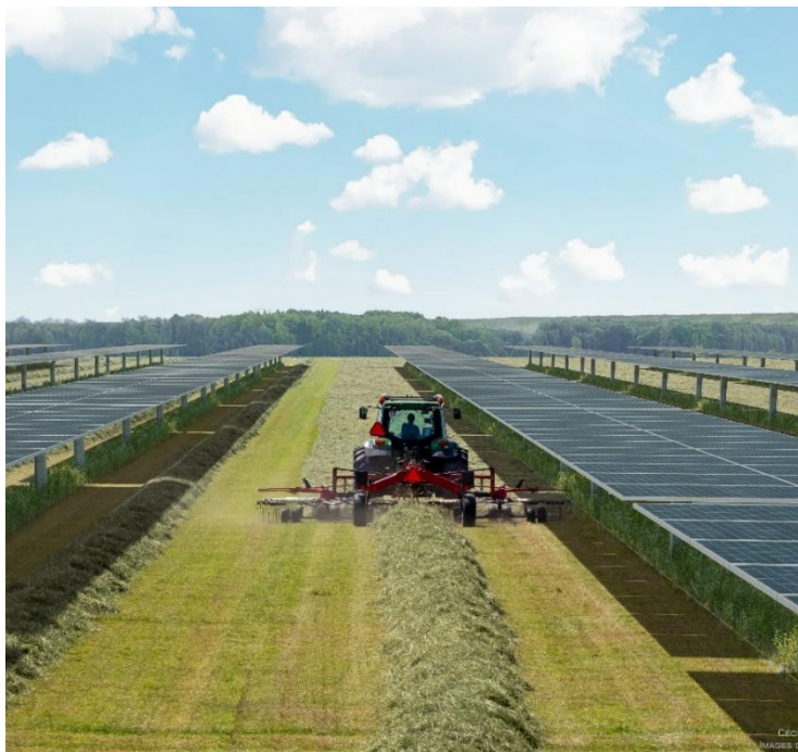
Exemple de centrale agrivoltaïque tracker 2V26 avec travaux d'andainage du foin 12m d'inter-rang et panneaux à l'horizontale (source JPee)
