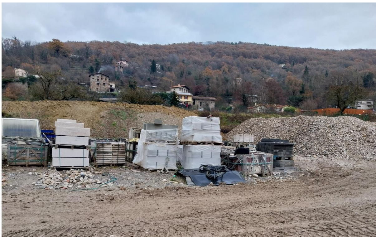
Figure 2 : Photographie des stocks de matériel de construction de gros œuvre (ICTP 2024)
