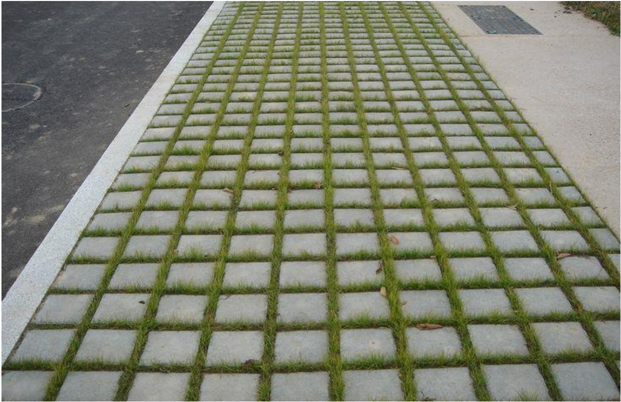
Exemple de pavé joints herbeux 1:1,57
