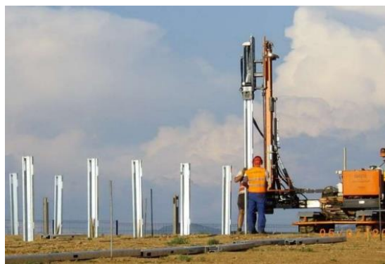
Figure 3 : Exemple de batteuse hydraulique
