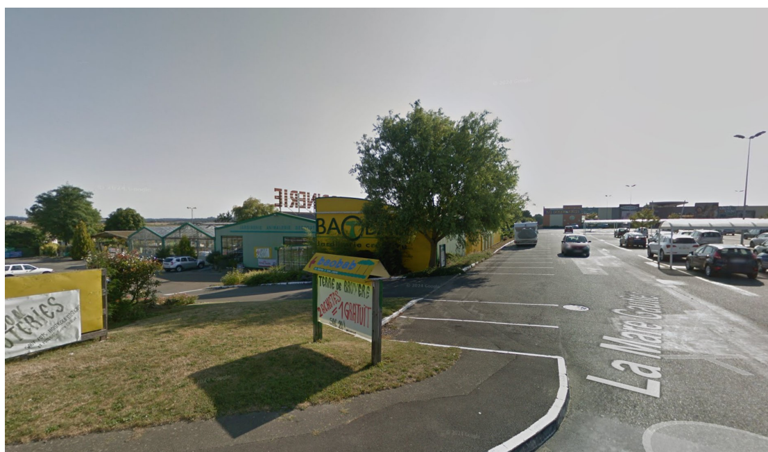
Arbre conservé au droit de la connexion entre la jardinerie et le parking attenant
