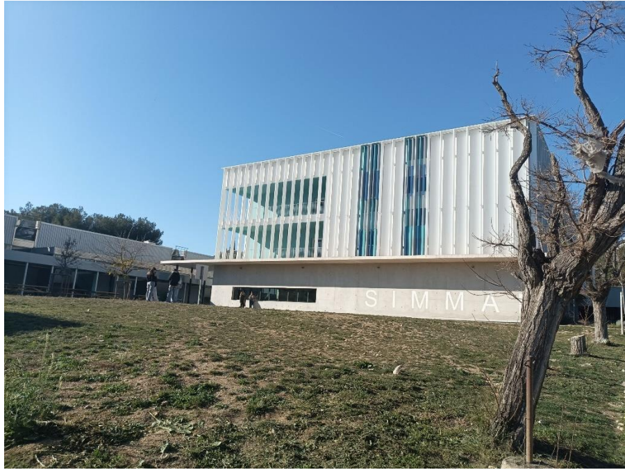
Figure 1 : Le bâtiment SIMMAR (source : Inddigo, 2025)
