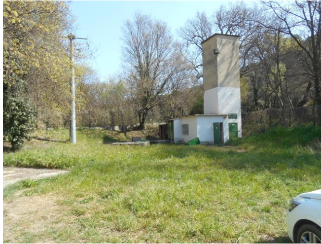
Photo 1 : Champ captant du Gravier (forage F1)
