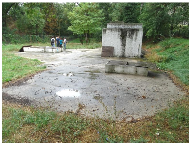
Vue générale du champ captant où l'on voit les margelles de deux forages (F1 et F3) et le bâtiment utilisé pour la chloration
