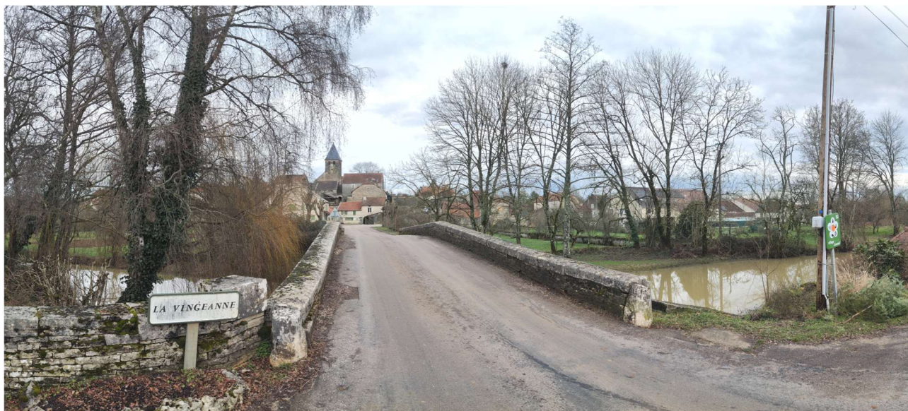
Vue depuis le pont de la Vingeanne (MH) en direction de la ZIP.
