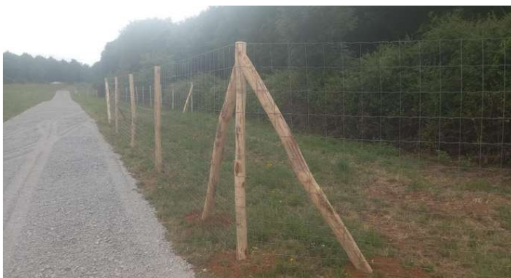
Figure 6 : Exemple de clôture poteaux bois
