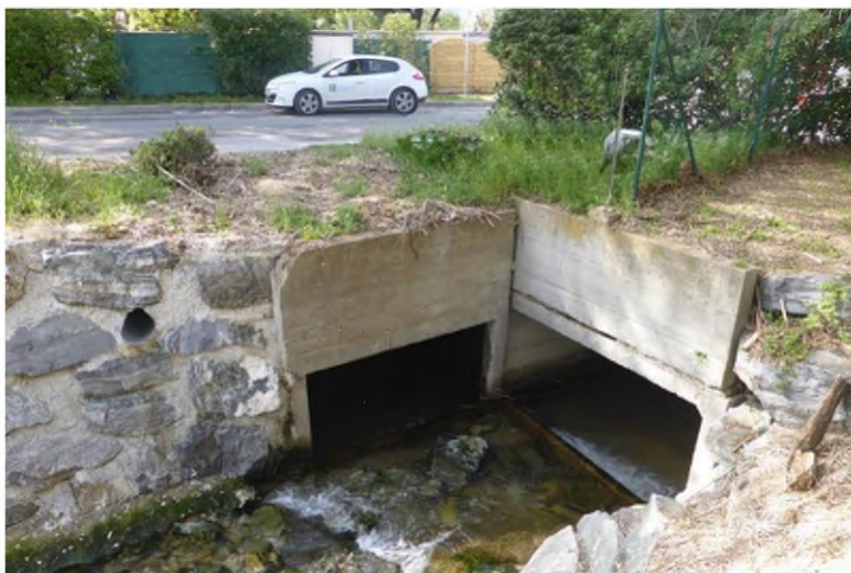
Vue de l'entonnement du double dalot en situation actuelle
