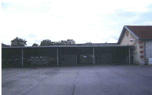
Figure 36 : Bâtiment 0050 – stockage couvert
