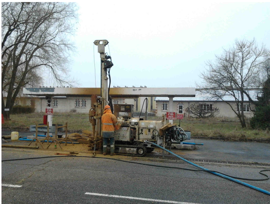
Forages au niveau de la station-service
