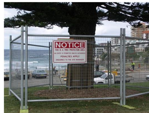
Figure 10 : Protection des arbres pendant le chantier
