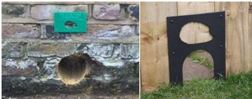
Figure 7 : Passage au sol dans un muret en pierre et dans une clôture
