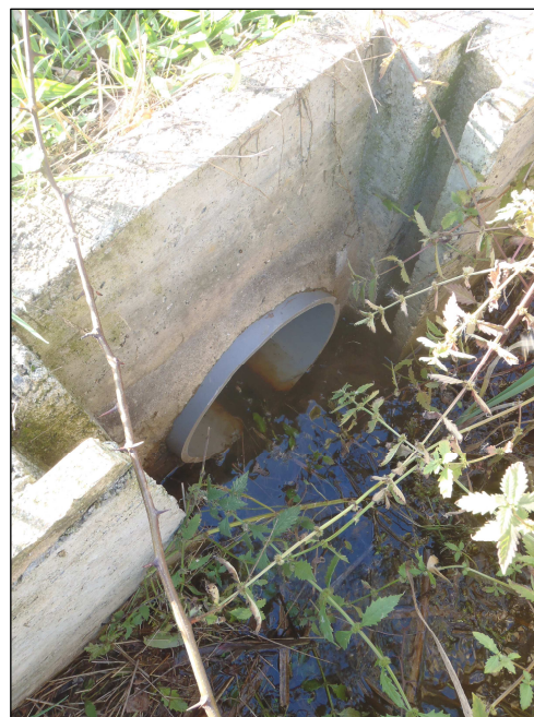
Vue de l'ouvrage de sortie du bassin
