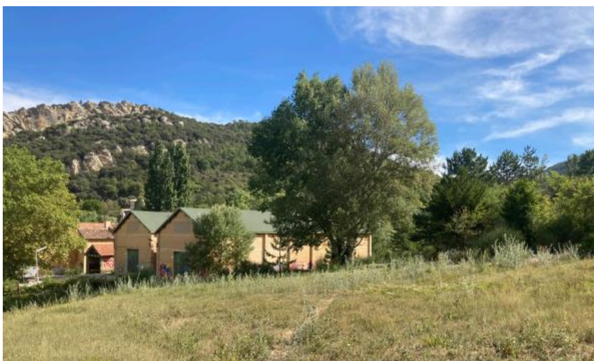
Vue depuis la limite sud des hangars Source Rougerie Tangram février 2025
