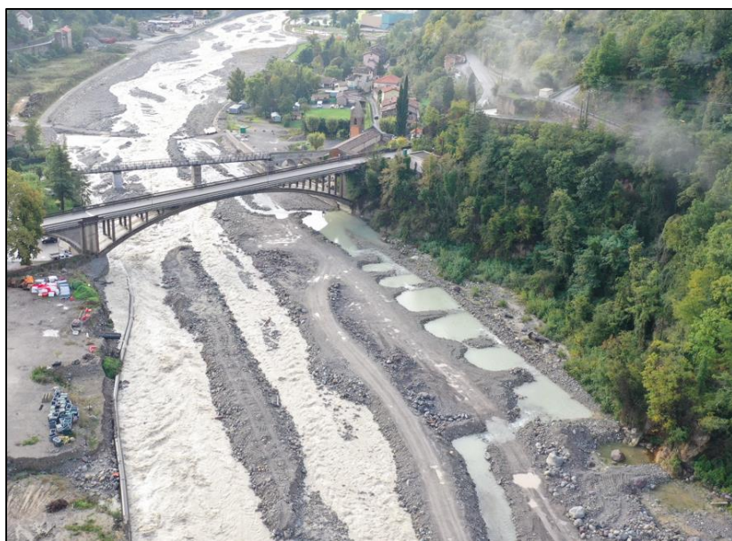
Exemple de bassin de décantation en série sur la Vésubie
