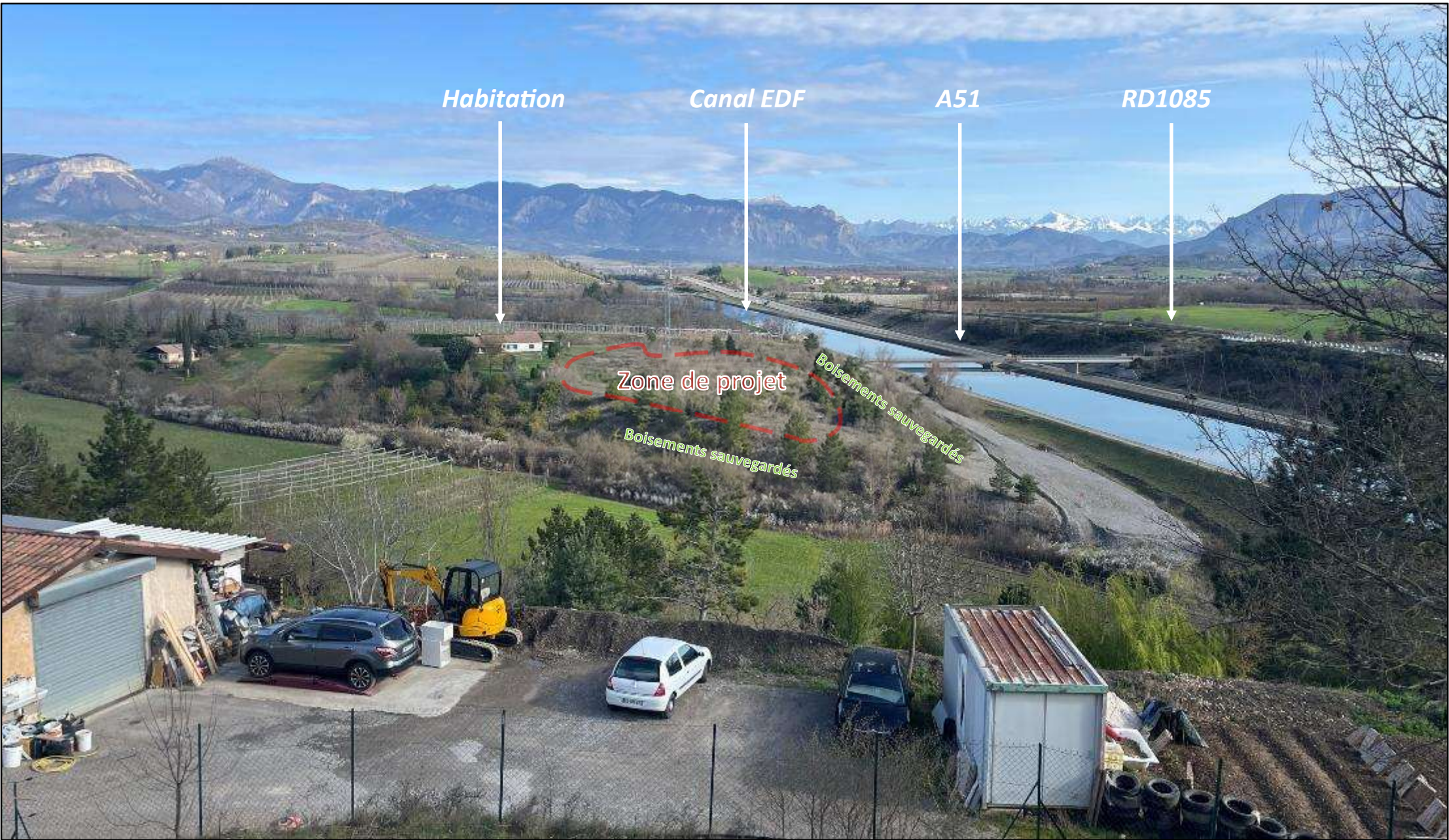
④ Vue éloignée (200 m) depuis le versant nord du village du Poët
