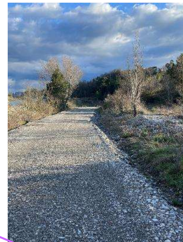
Liaison souterraine RTE
