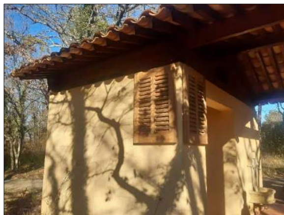
Face sud avec chiroptères et faux-volets
