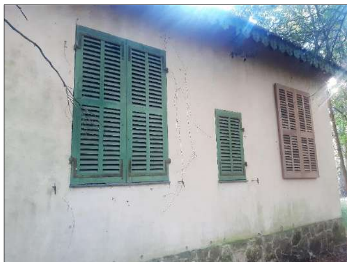
Face ouest avec faux-volets
