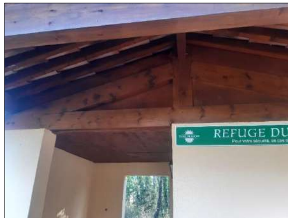
Face ouest comblée au niveau de la charpente et fermeture du faux plafond avec trappe d'accès
