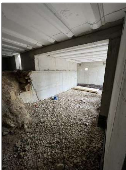
Aménagement en cours de la Ferme Bouge
