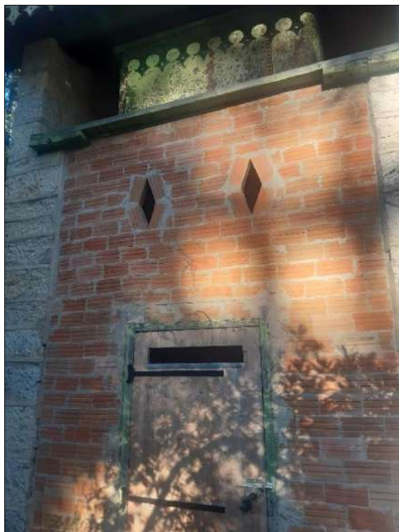
Entrée de la tour avec vu sur la chiroptère au-dessus de la porte et maintien des lucarnes en losange ouvertes
